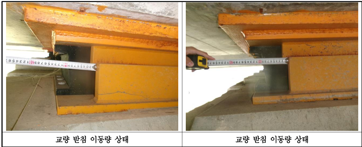
【사진 37.3.15】 교량받침 이동량 측정
