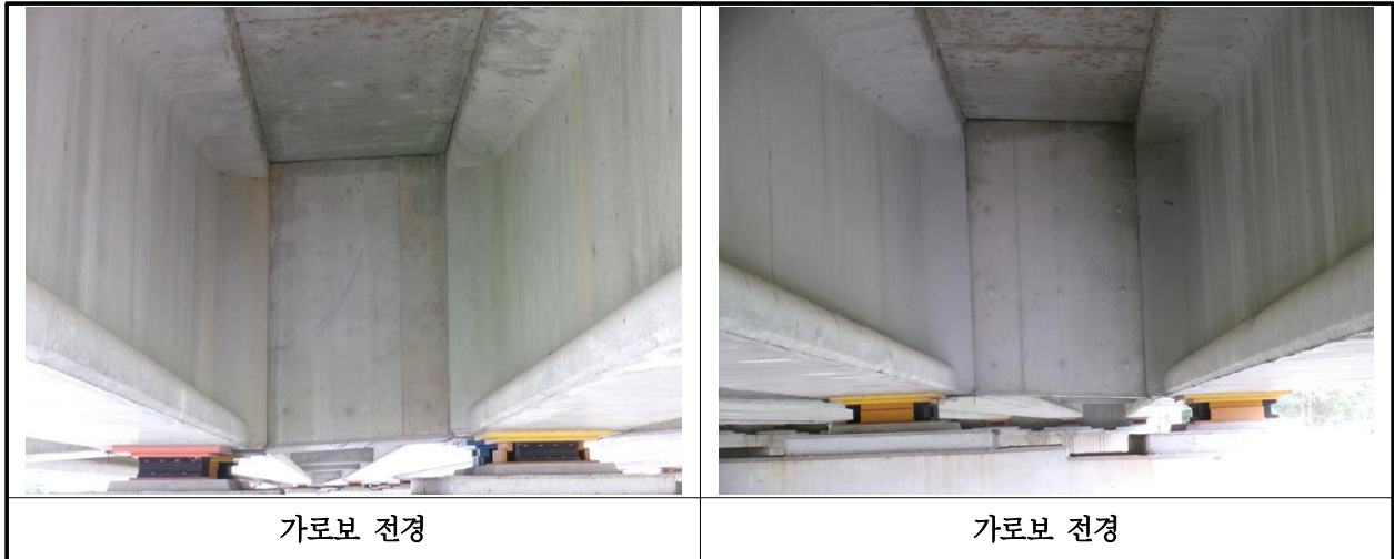
【사진 37.3.6】 가로보 전경
