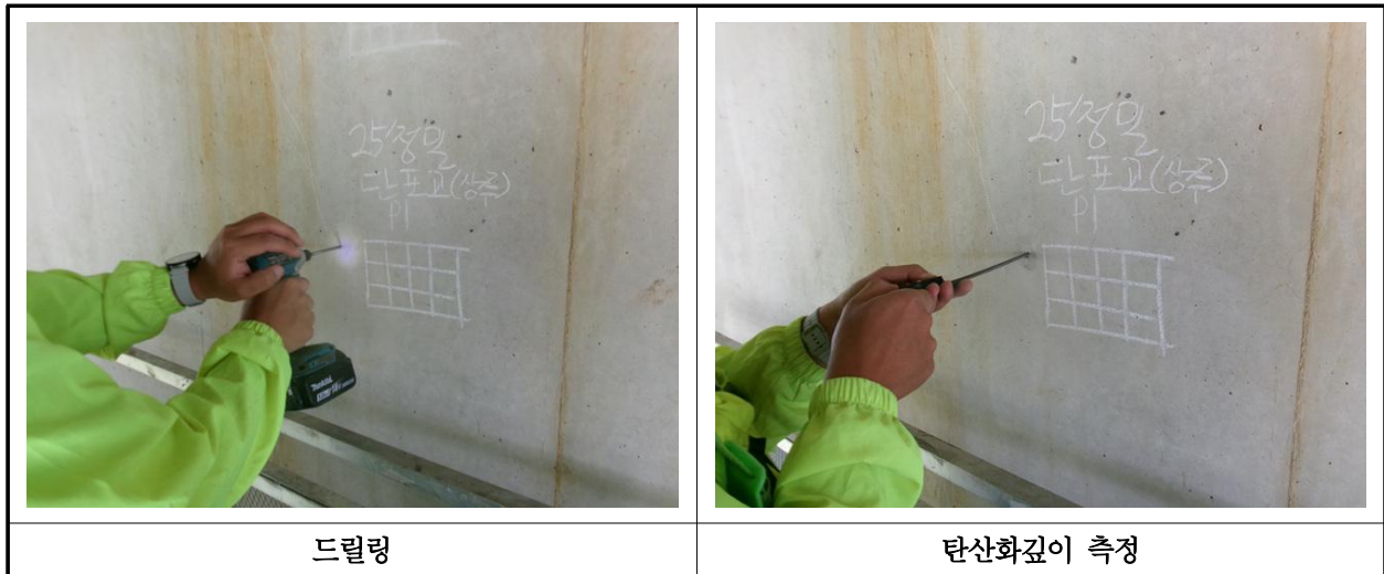
【사진 37.4.3】 탄산화 깊이 측정 현장사진
