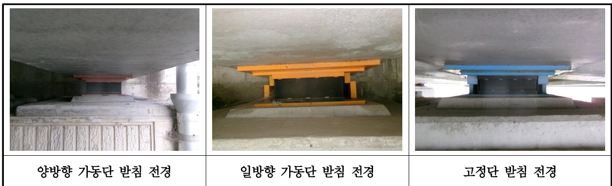
【사진 37.3.12】 교량반침 전경
