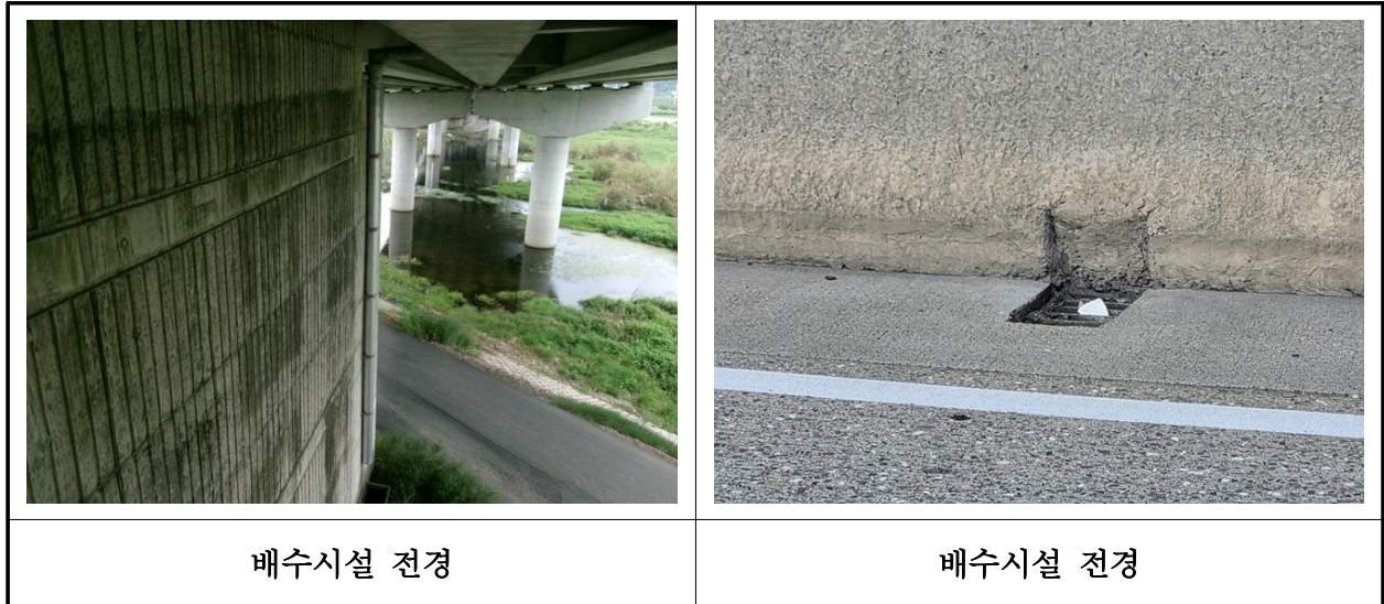
【사진 37.3.44】 배수시설 전경
