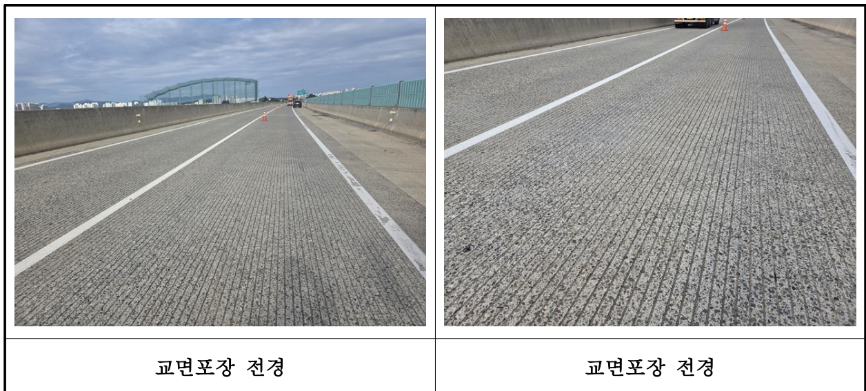
【사진 37.3.19】 교면포장 전경
