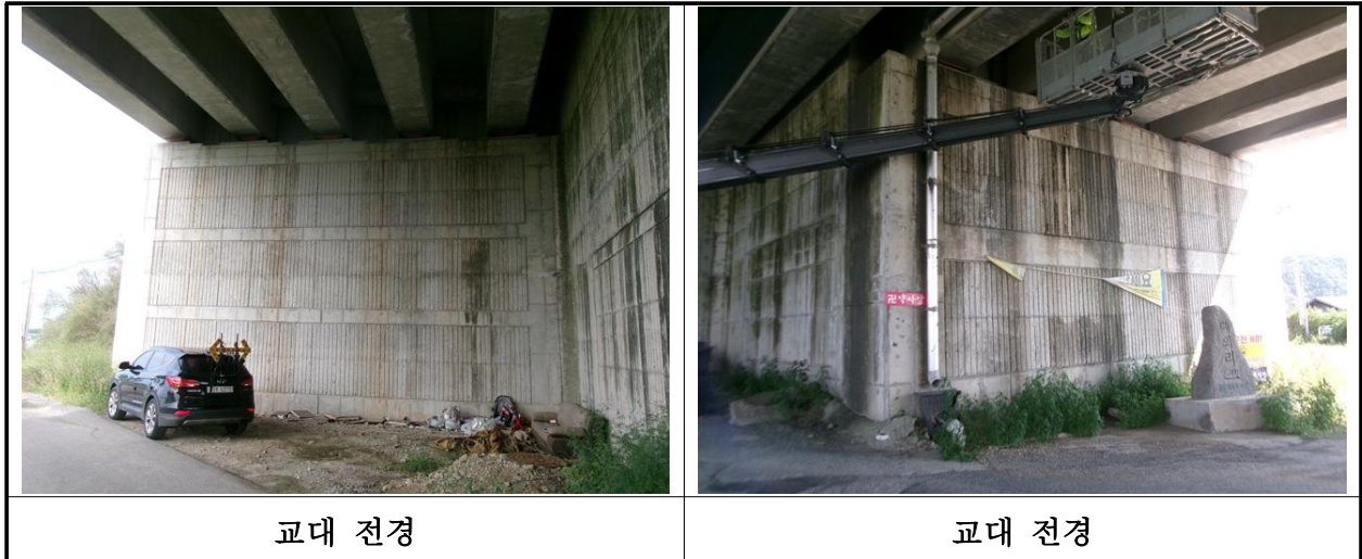
【사진 37.3.31】 교대 전경
