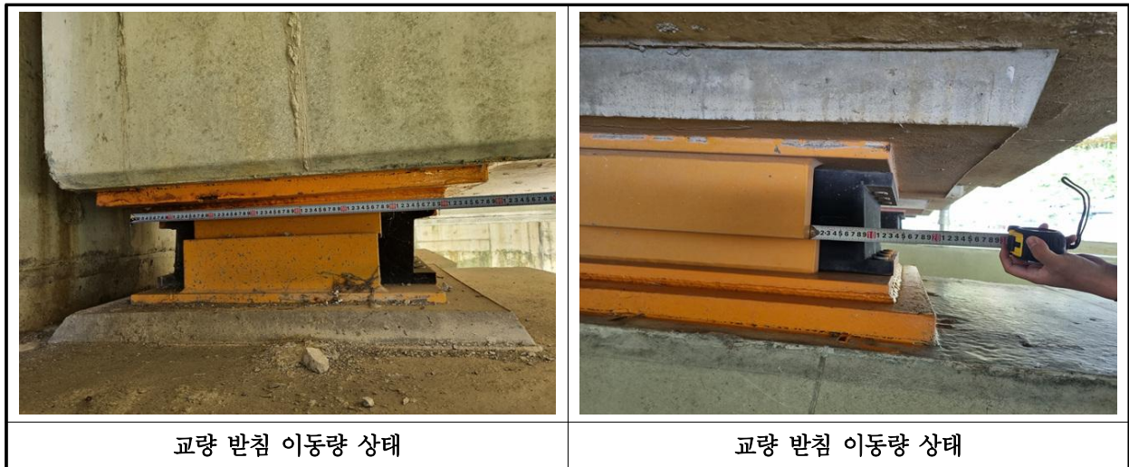
【사진 37.3.38】 교량받침 이동량 측정
