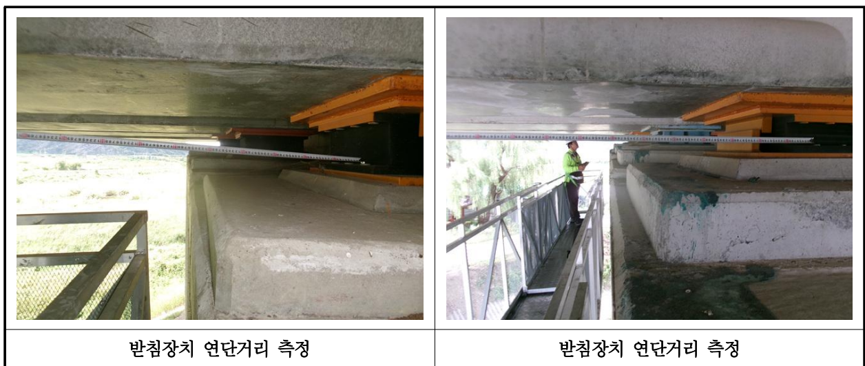
【사진 37.3.14】 교량받침장치 연단거리측정
