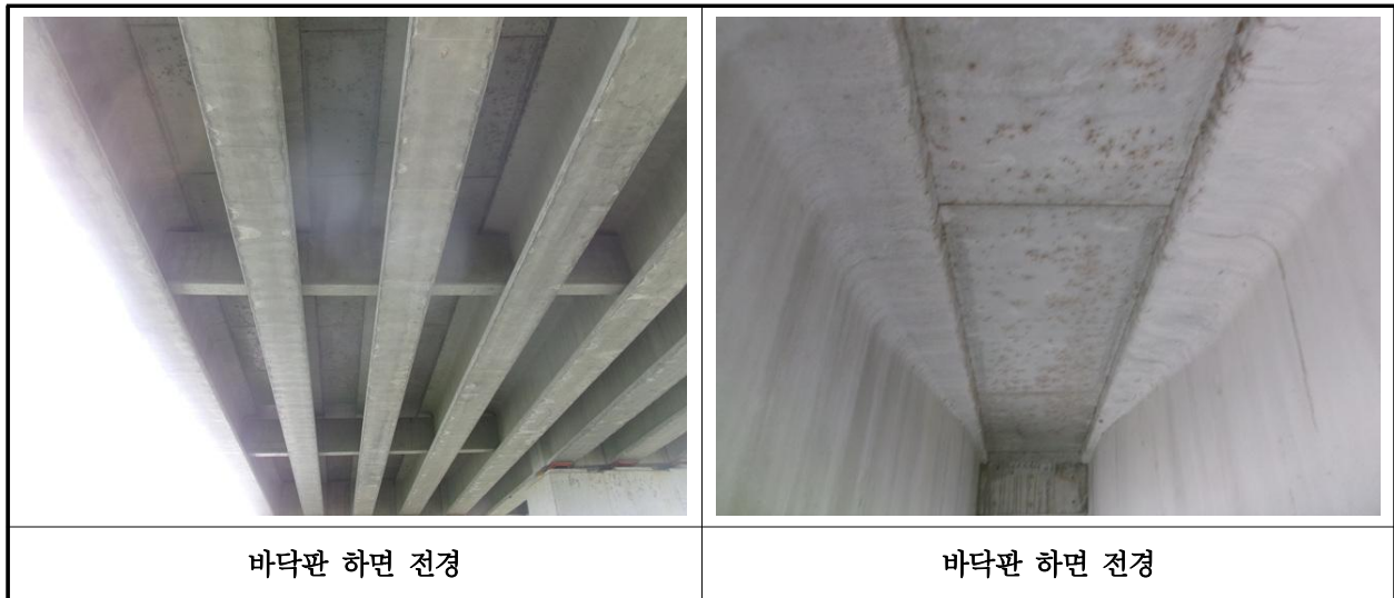
【사진 37.3.2】 바닥판하면 전경
