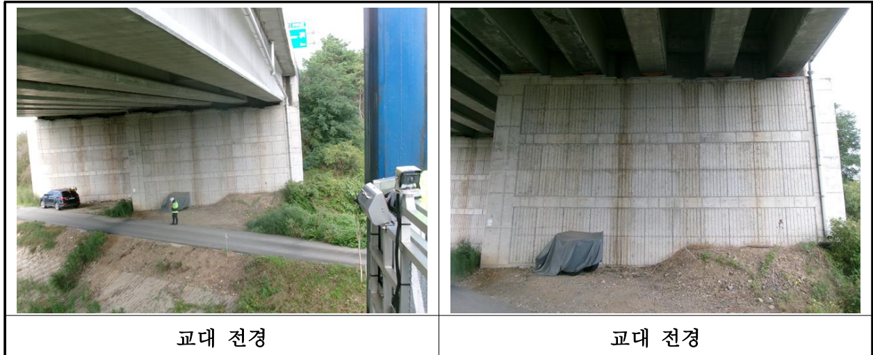
【사진 37.3.8】 교대 전경
