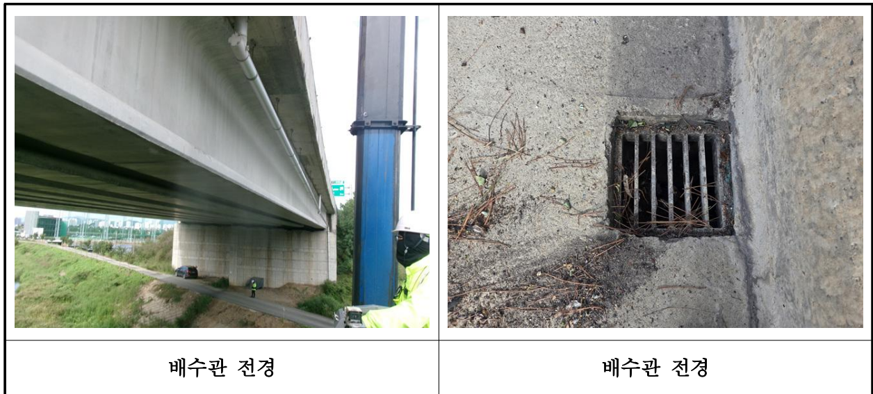
【사진 37.3.21】 배수시설 전경
