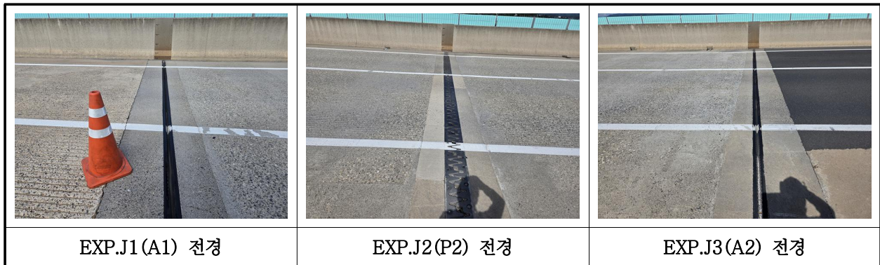
【사진 37.3.39】 신축이음장치 전경
