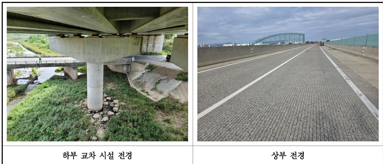
【사진 37.2.1】 부재 현장측정 전경
