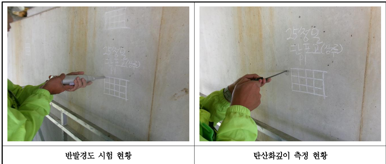
【사진 37.4.1】 콘크리트 내구성조사 현황
