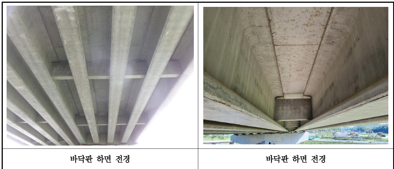
【사진 37.3.25】 바닥판하면 전경
