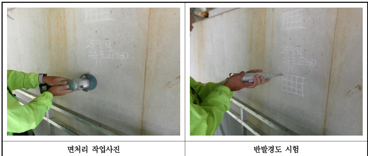
【사진 37.4.2】반발경도시험 현장사진
