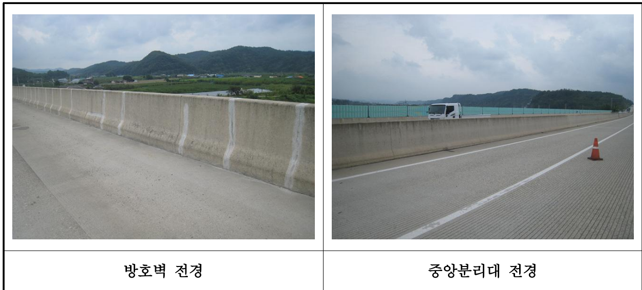
【사진 37.3.46】 방호벽 및 중앙분리대 전경
