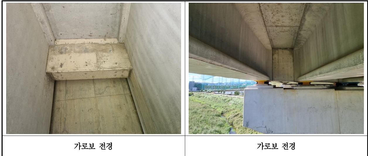
【사진 37.3.29】 가로보 전경
