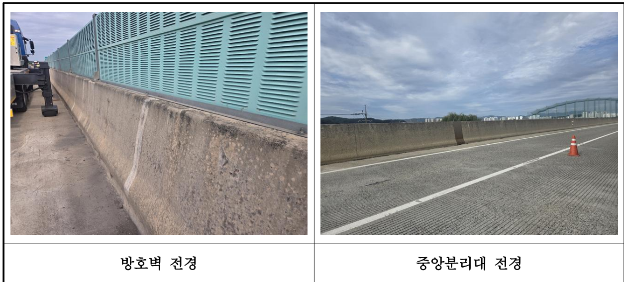
【사진 37.3.23】 방호벽 및 중앙분리대 전경
