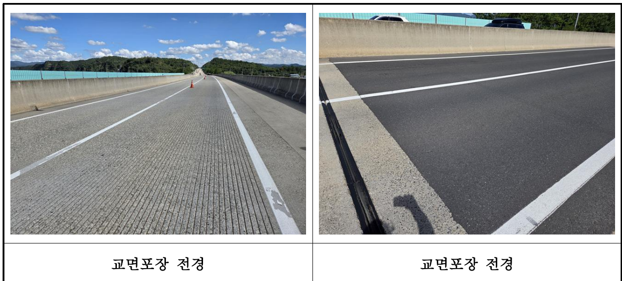
【사진 37.3.42】 교면포장 전경
